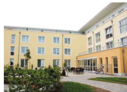
Rezidence seniorů Regensburg-Burgweinting: Centrální řízení jednotek M-WRG a využití hospodárného řešení pro 2 místnosti.
